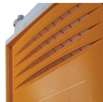
Les parois ultra lisses peuvent être lavées facilement, les grilles d'aération inamovibles intégrées protègent la cabine de la pluie et assurent une bonne ventilation à l'intérieur de la cabine même lorsque les températures extérieures sont élevées. Le toit est traité contre les rayons UV et résiste aux conditions climatiques extrêmes.
